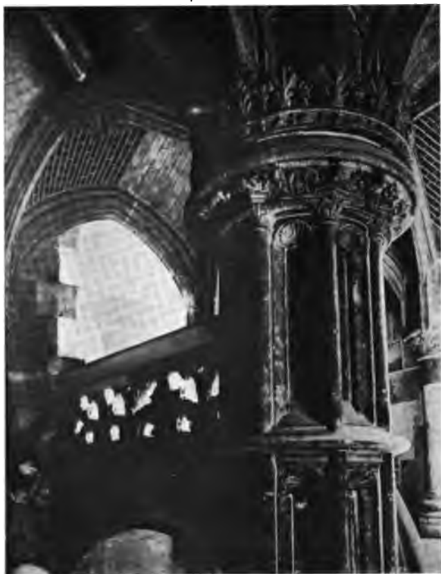
Fig. 101. — Couronnement de l'escalier à vis de l'aile Louis XII au château de Blois. Décoration de la surface du noyau par des niches et des colonnettes.
